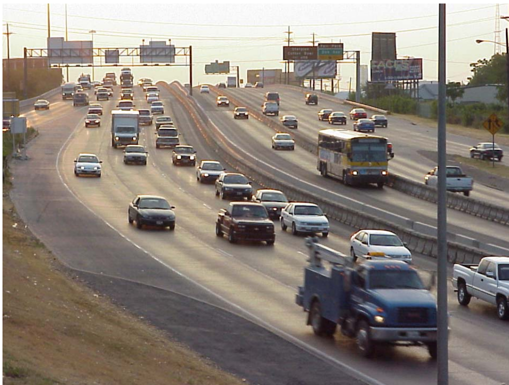
Figure 1. IH-30 (ERLT) Contraflow HOV Lane (Dallas, Texas).
